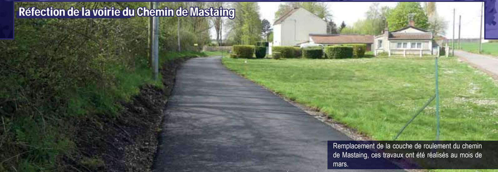
Remplacement de la couche de roulement du chemin de Mastaing, ces travaux ont été réalisés au mois de mars.
